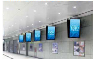
新大阪駅 3階東西自由通路 60インチ 10面
